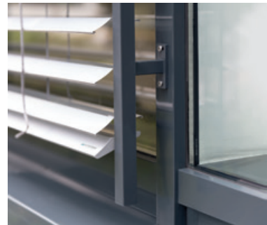
Führungsschiene mit Abstandhalter
